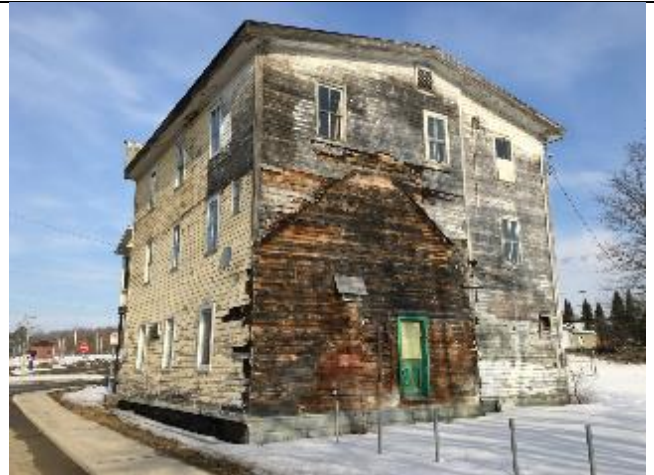
Photo 4 : Façade arrière / latérale gauche (mars 2020) Source : Ville de Gatineau
