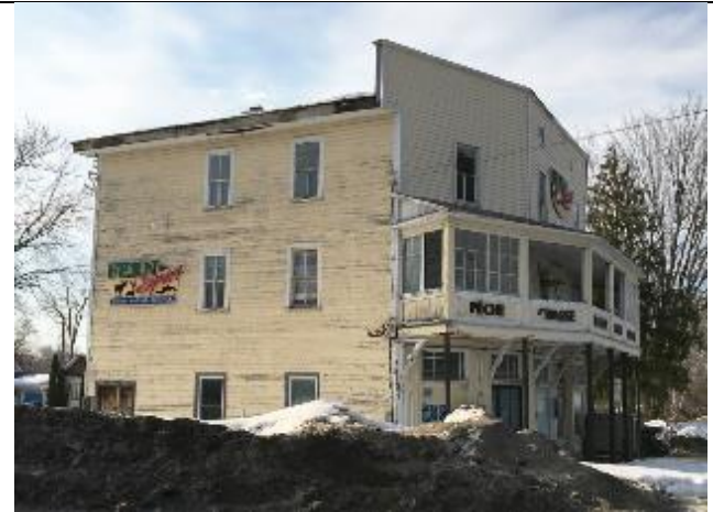
Photo 5 : Façade latérale gauche (mars 2020) Source : Ville de Gatineau
