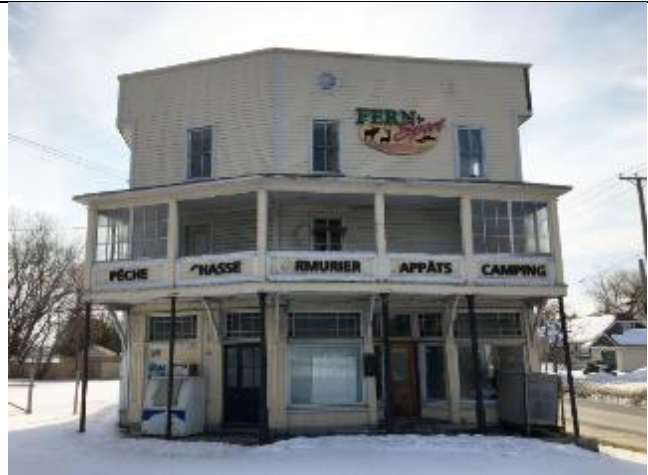
Photo 3 : Façade avant (mars 2020) Source : Ville de Gatineau
