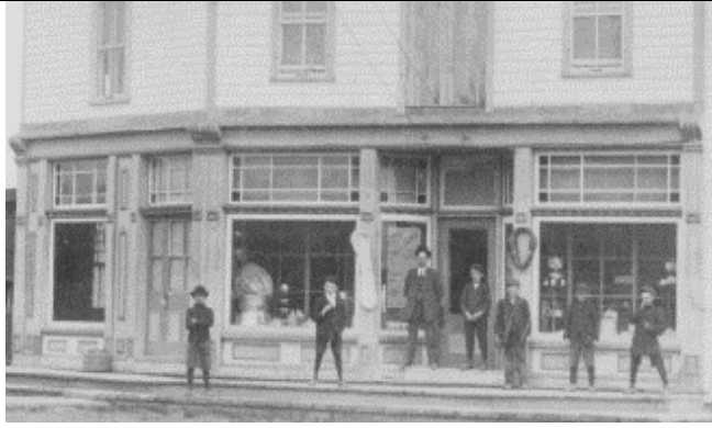
Photo 1 : Détail des boiseries de la façade avant (vers 1910) Source : Jean-Yves D'Aoust
